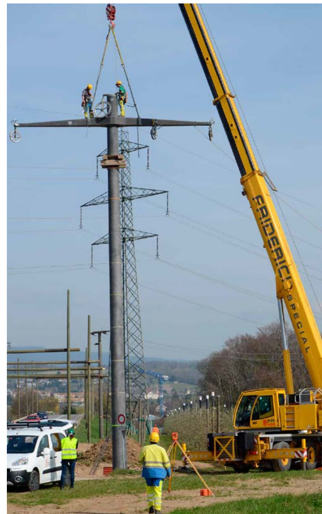
Renforcement du réseau haute tension de La Côte (8 chantiers; 2000 - 2014)
