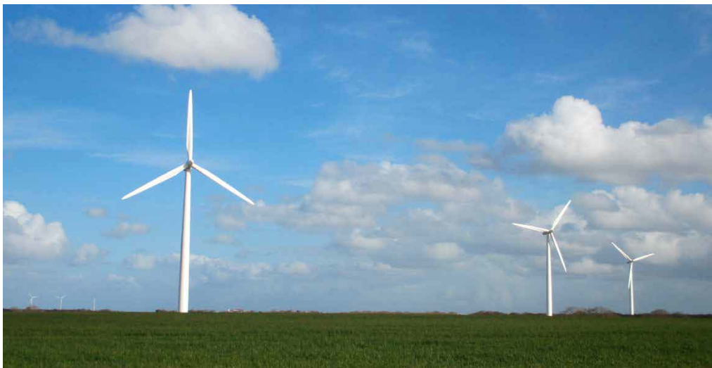
Acquisition d'un parc de 7 éoliennes en Bretagne (F)
